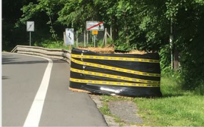
Tehlikeli yerler için saman balyası yerleşimi
