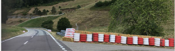
Yarışmacıları korumak için saman ve lastiklerin doğru kullanımı
