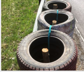
Doğru İmal edilmiş Lastik Bariyer
